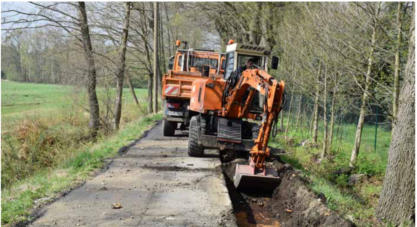
Straßenbau für Umleitungen zwischen Straßgräbchen und Bernsdorf
