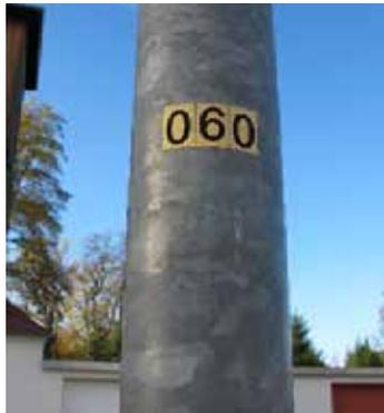
Einigen sind diese Nummern bereits bekannt, wenn Ausfälle gemeldet werden. Die Straßenlaternen der öffentlichen Straßenbeleuchtung werden in einem Anlagenverzeichnis mit einem Ortsbezug und einer Nummer geführt und sind vor Ort direkt am Mast mit eben dieser Nummer gekennzeichnet.
