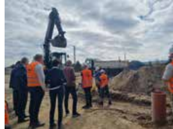
Heinz Lange Spezialtiefbau GmbH, Laußnitz
