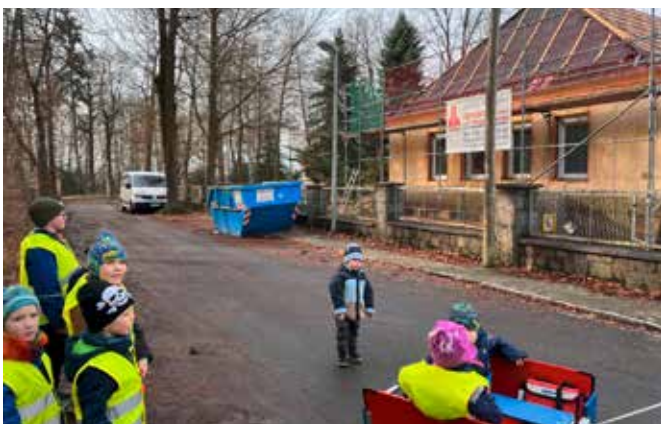
Stippvisite auf unserer „Kita“-Baustelle Wiednitz
