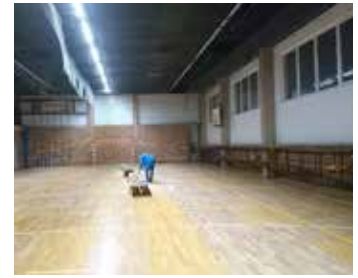
Im März 2018 wurde die neue Beleuchtung montiert und hat sich seitdem bewährt
