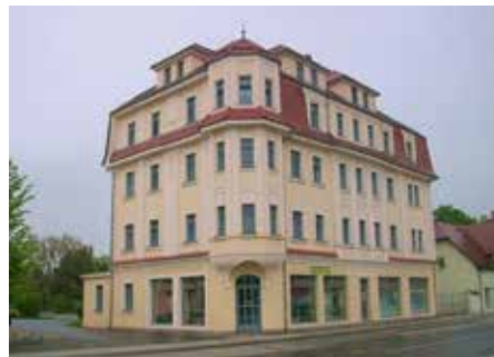
... und nach der Restaurierung
