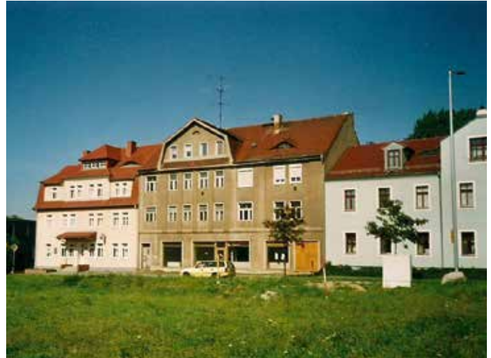
Das Gebäude Ernst-Thälmann-Straße 24 vor der Sanierung ...
