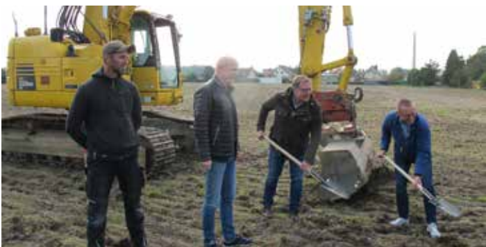
Offizieller Spatenstich zum Beginn der Erschließung der 25 Baugrundstücke im Oktober
